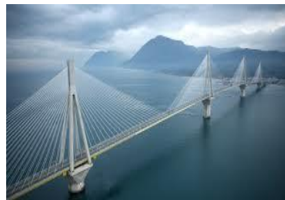
Γέφυρα Ρίου - Αντίρριου
