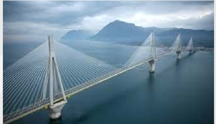
Γέφυρα Ρίου - Αντίρριου
