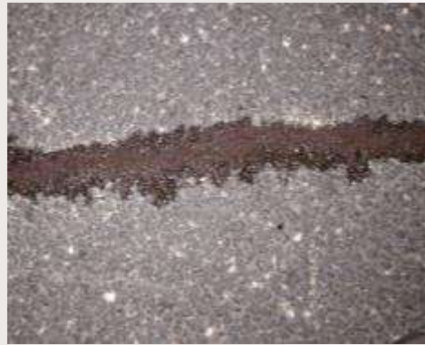
Στεγανοποίηση ρωγμών οδοστρώματος
