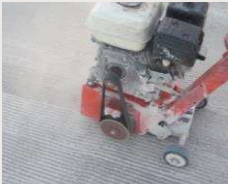
Οδόστρωμα σταθμών διοδίων: βελτίωση αντιολισθηρότητας με φρεζάρισμα (milling)
