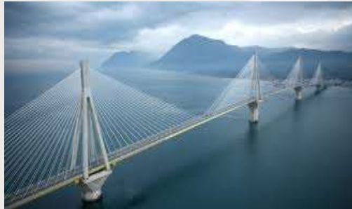
Γέφυρα Ρίου - Αντιρρίου
